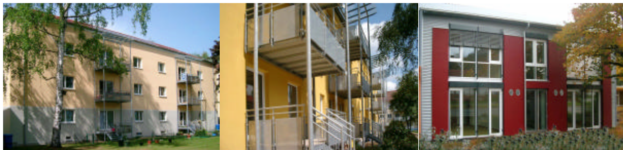
Abb. 1 WBG (2003): Jean-Paul-Platz, Nürnberg, Heizwärmebedarf von 204 auf 26 kWh/(m 2 a)
