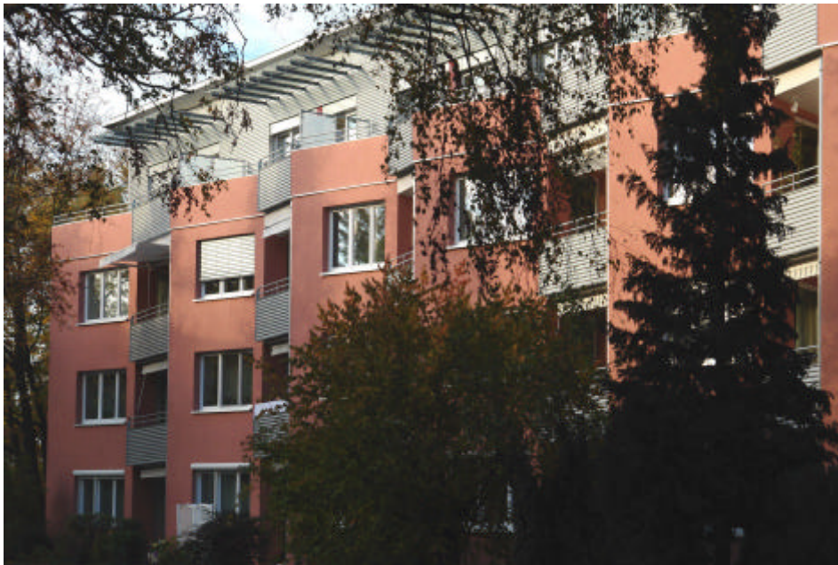
Abb. 2 Mehrfamilienhaus Bernadottestraße 42 – 48 in Nürnberg: Faktor-10-Sanierung bei den drei Bestandsgeschossen, Passivhaus-Standard für die sechs neu errichteten Wohnungen im vormaligen Dachboden-Bereich (Bauherr: wbg Nürnberg, Sanierung 2006)
