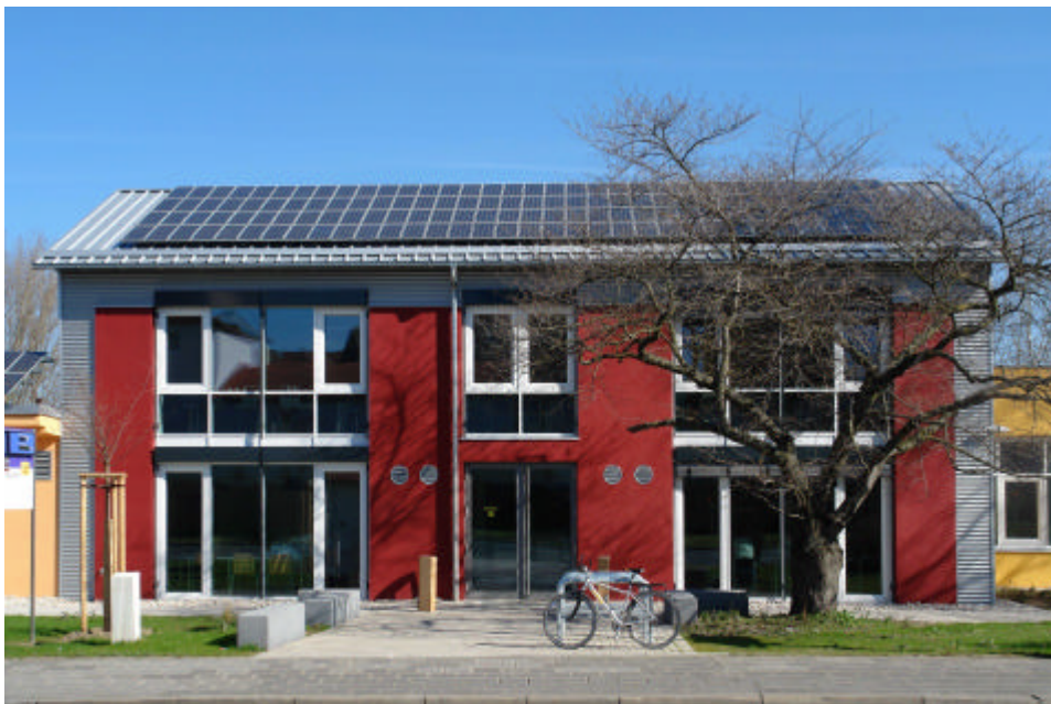
Abb. 1 Seminargebäude der Beschäftigungsgesellschaft ELAN in Fürth: Passivhaus-Neubau in Verbindung mit Faktor-10-Sanierung der angrenzenden Bestandsgebäude (Bauherr: Stadt Fürth, Baujahr 2005)
