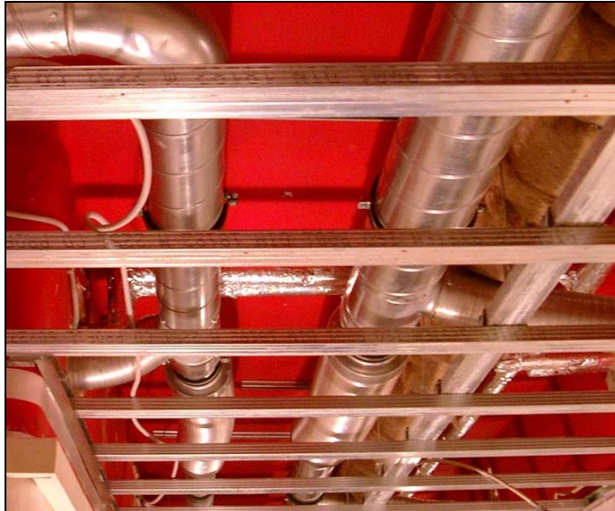
Abb. 2 Leitungsführung unter der Decke im Flur
