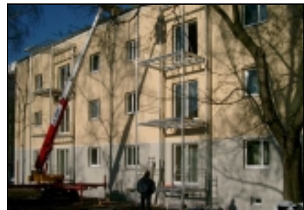
Abb. 2: Kurz vor Fertigstellung
