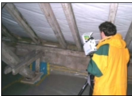
Abb. 5: Thermografie der Dachboden-Luftdichtung
