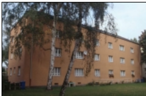
Abb. 1: Vor der Sanierung
