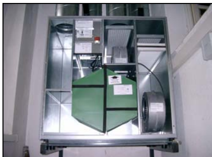
Abb. 9: Lüftungsgerät - Innenansicht
