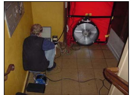
Abb. 7: Blower-Door-Messung – n_{50} vorher 4,9 \text{ h}^{-1} nachher 0,35 \text{ h}^{-1}
