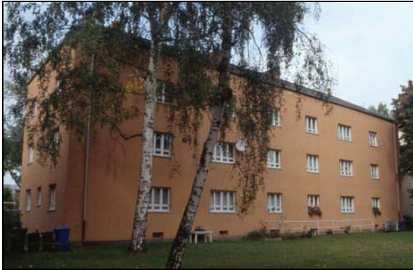
Abb. 1: Vor der Sanierung
