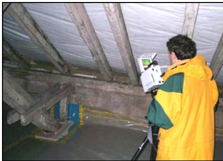
Abb. 5: Thermografie der Dachboden-Luftdichtung
