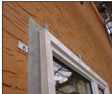
Abb. 6: Luftdichtung der Fenster außenwand-bündig
